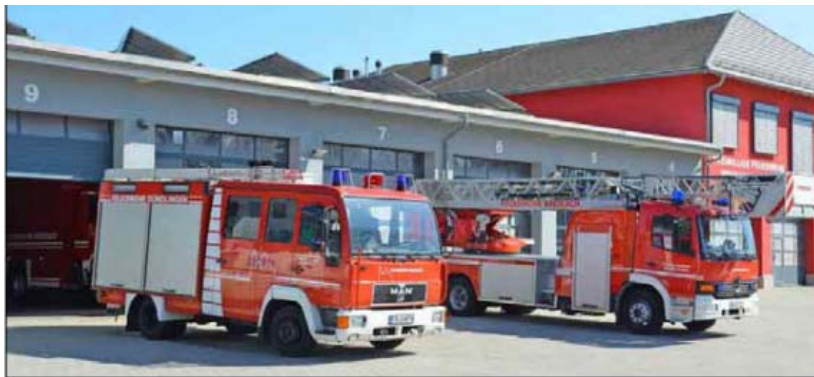
Am Feuerwehrhaus in Breisach müssen 8 Jahre nach Fertigstellung bereits einige Reparaturen vorgenommen werden. FOTO: THOMAS RHEINISCH
