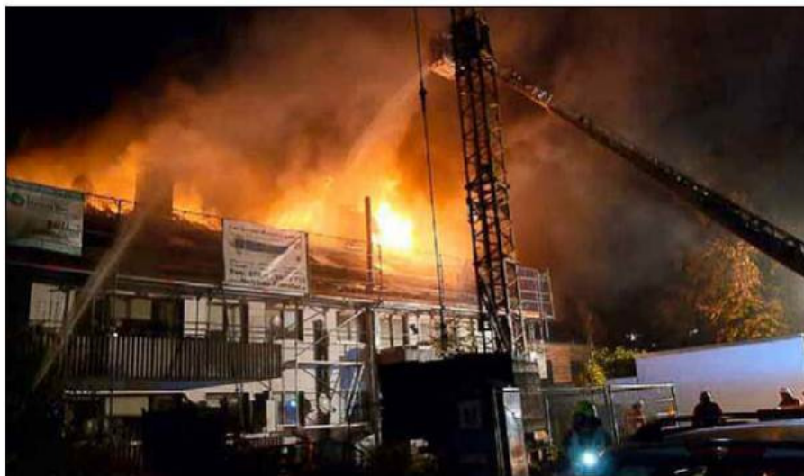
Bei einem Dachstuhlbrand in Niederrimsingen entstand immenser Schaden am Gebäude.
