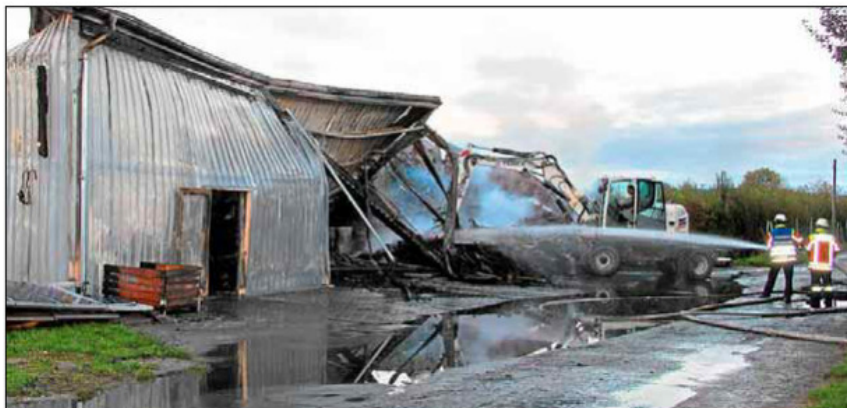
Vollkommen zerstört wurde ein landwirtschaftlicher Schopf in Niederrotweil durch einen Brand im Bereich „Hintere Mühle“ in der Nähe vom Sportplatz des TuS Oberrotweil. FOTO: HERBERT TROGUS
