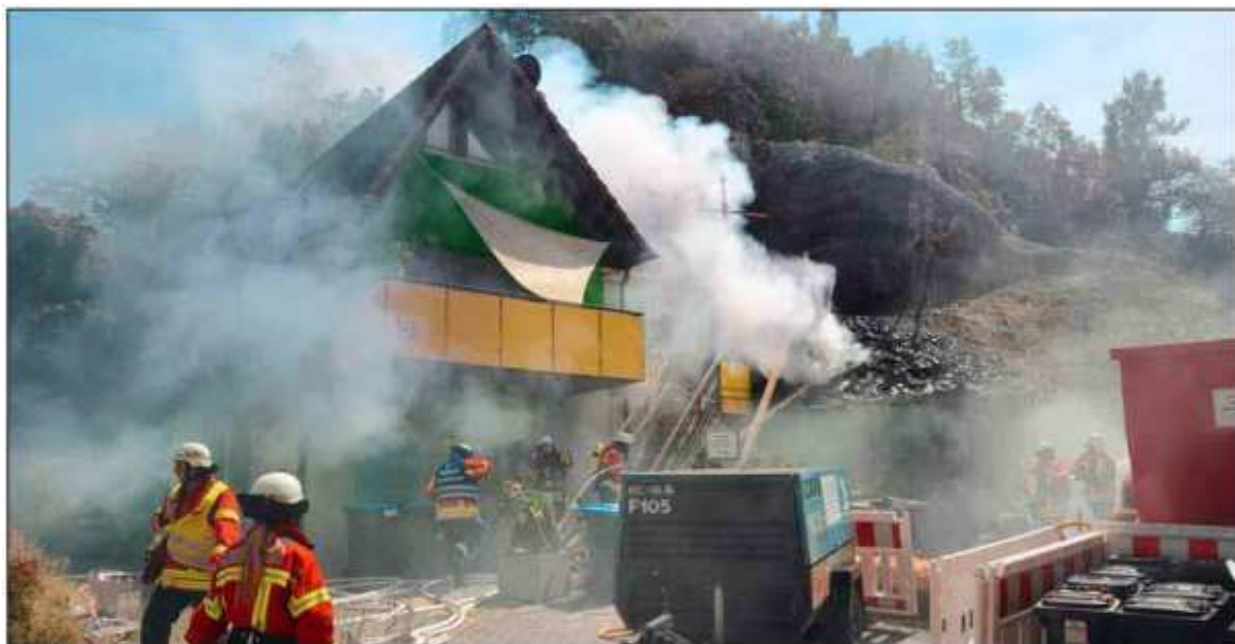
Glimpflich verlief gestern ein Brand in der Marienau in Breisach. Stroh hatte bei Flexarbeiten an der Felsabsturzstelle am Eckartsberg Feuer gefangen. Die Feuerwehr konnte ein Übergreifen der Flammen auf das benachbarte Haus verhindern. FOTO: GEROLD ZINK
