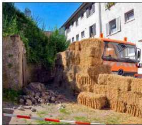
Zum Schutz der Anwohner und der Häuser wurden in der Marienau Strohhallen und Container aufgestellt.
