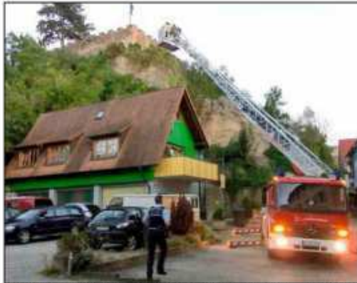
Experten untersuchten von der Drahtleiter der Feuerwehr aus, ob die Gefahr besteht, dass weitere Steine vom Eckartsberg herabstürzen.
