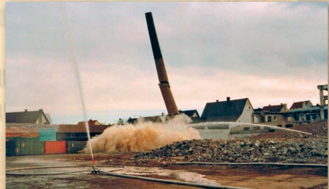
Sprengung des 30 Meter hohen Kamins
