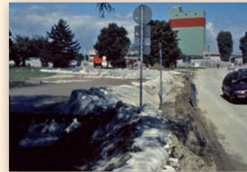
Sandsackwall an der Panzerrampe
