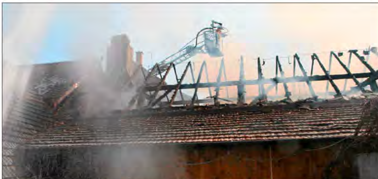
Der Dachstuhl des Ökonomiegebäudes des Weingutes Bercher-Schmidt wurde weitgehend zerstört.
